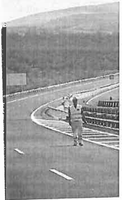
Vista del tramo de la A32 entre
